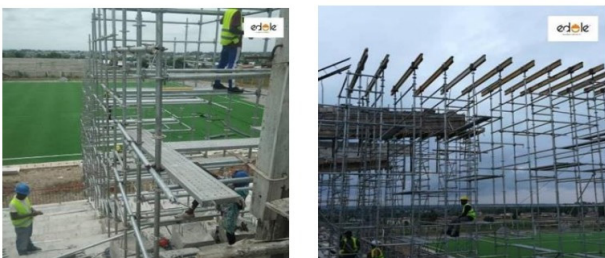
▪ FOURNITURE DE RESSOURCES MATÉRIELLES ET HUMAINES SUR LE SITE DES TRAVAUX DE CONSTRUCTIONS DU STADE DE NOTSE
