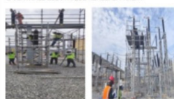
FOURNITURES DE RESSOURCES MATÉRIELLES SUR LE P E CENTRALE ÉLECTRIQUE KEKELI EFFICIENT
